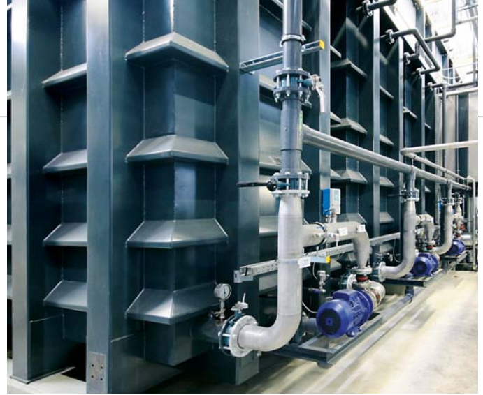
Detailaufnahme des Beckenbereichs auf der 0-Meter-Ebene mit einem zentralen Teil der Verrohrung.
